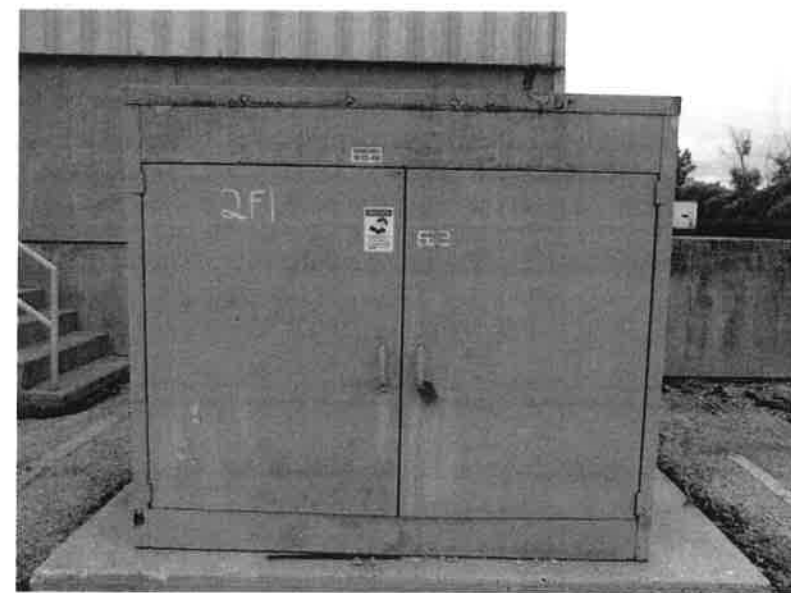
4 EXISTING TRANSFORMER SCALE: N.T.S.
