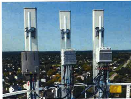
2 PHOTO OF ANTENNA LEVEL SCALE: N.T.S.
